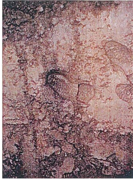
粘性土：粘性土が主体で常に軟らかい状態である。手でさわると「ベタベタ」で、極めて軟らかい状態である。ブルドーザーの走行が困難である。人が歩くと長靴がはまり込む。 (第4種)
