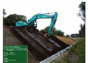
法面整形(ICT)
