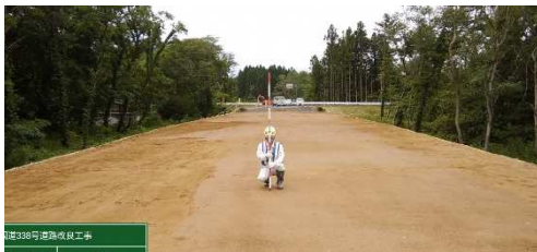
完成（本線土工）
