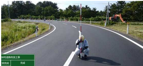
完成（取付県道舗装）
