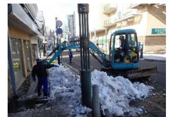
【歩道部の除排雪】
