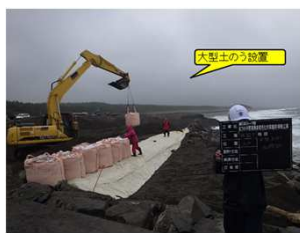
土木シート展張後大型土のう設置
