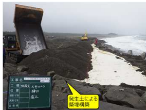
現地発生土による築堤
