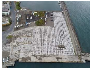
1工区製作ヤード
