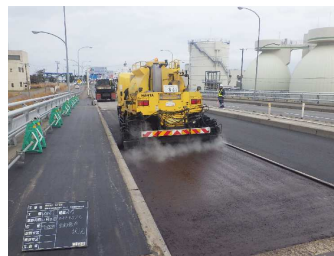
【分解促進型タックコートの施工】
