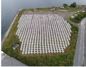
2工区製作ヤード
