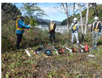
写真2 伐採作業状況 (作業前ミーティング)
