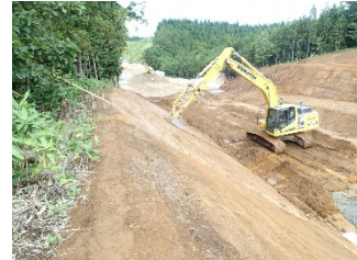
【ICT土工施工状況】
