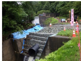
暗渠管の離脱防止対策
