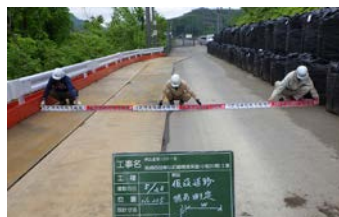
【砂子瀬ゲート拡幅工事】
