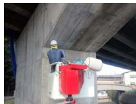
集塵機能付き工具での施工
