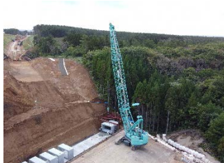
【PCボックスカルバート施工状況】
