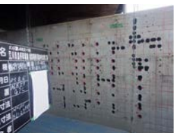
アンカー削孔
