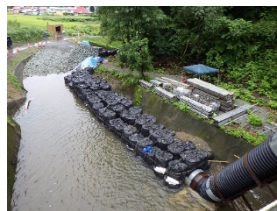
暗渠管の離脱防止対策
