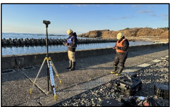
三次元点群測量状況（UAV）
