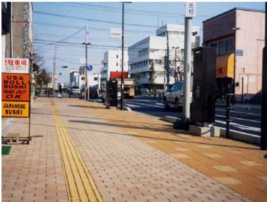
施工事例 三沢市市道32号
