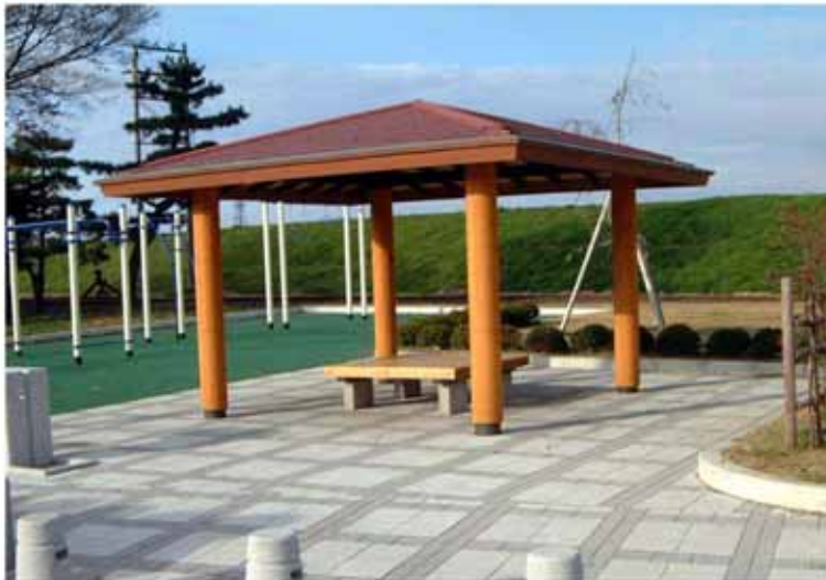
施工事例 まべち公園
