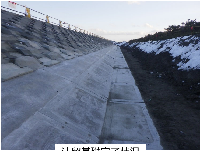
法留基礎完了状況
