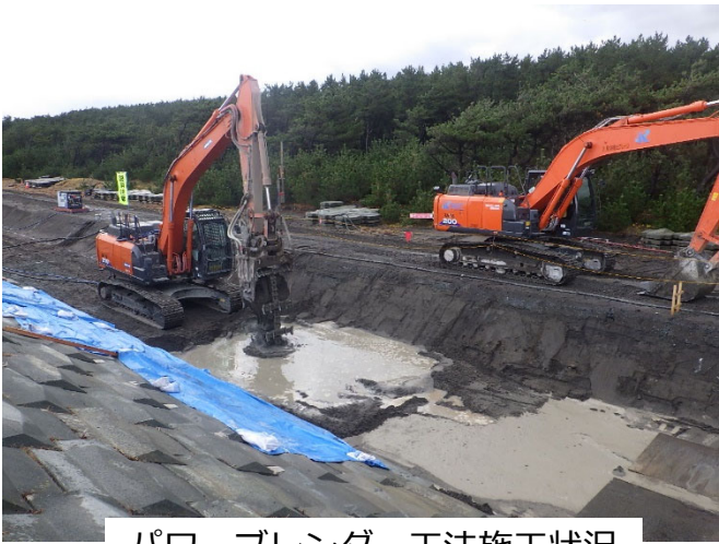
パワーブレンダー工法施工状況
