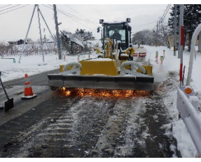
ロードヒーターの使用
