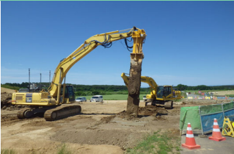
【 ICT中層混合施工状況 】
