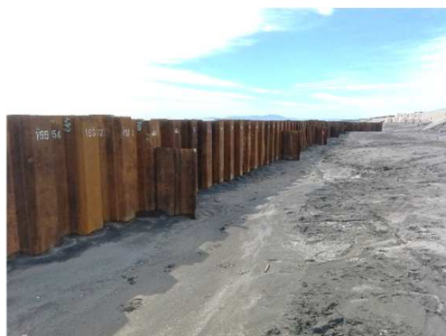
控え矢板の設置
