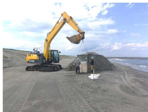
大型土のう製作器
