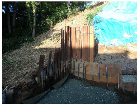
仮設簡易土留め設置状況
