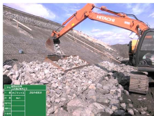
かごマット用鋼製型枠
