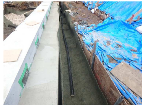
ドレーン材設置状況
