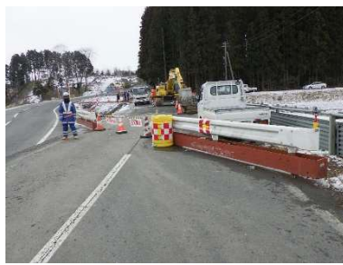
仮設ガードレール・クッションドラム設置状況
