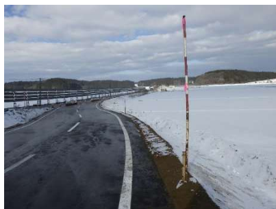
迂回路除雪のためのスノーポール設置状況
