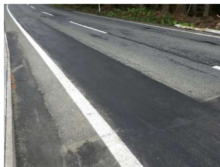
施工範囲外の舗装補修の実施
