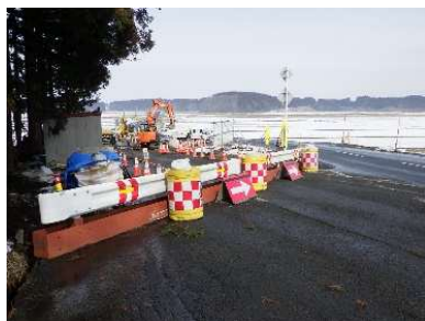
仮設ガードレール・クッションドラム設置状況
