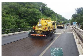
アスファルト乳剤施工状況 スーパータックゾール（NETIS）
