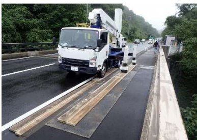
橋梁点検車使用時の舗装防護対応
