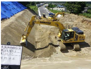
①ICT施工による切土整形
