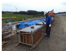
【コンクリート養生】 (NETIS活用)
