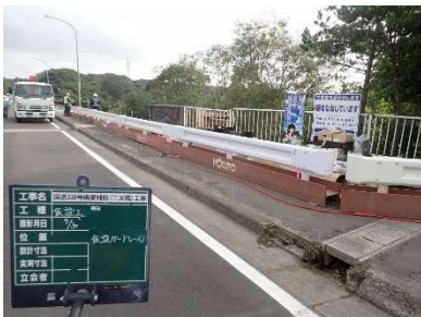
高欄撤去時の仮設ガードレールを使用した転落防止対策
