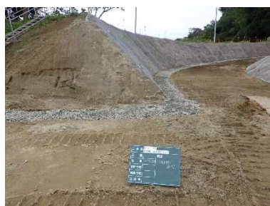
⑥碎石埋設による土砂の流出防止
