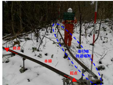
牽引車待避場所の設置状況
