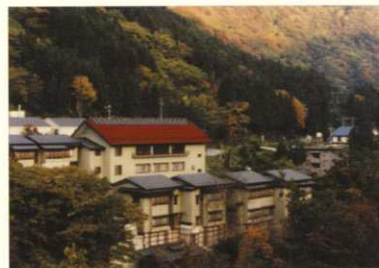
1棟の屋根が集落の景観を損なっています。
