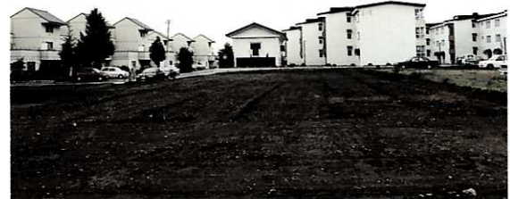
■形態、意匠及び色彩を統一し、まとまりのある住宅団地を形成している。
