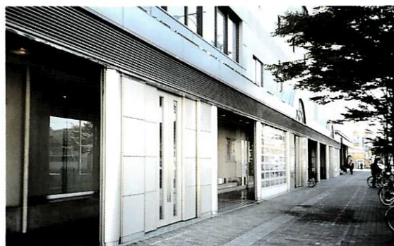
■ 建築物と一体化した防雪通路を設置している。
