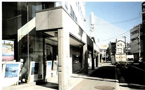
■ 建築物と調和した防雪通路を設置している。
