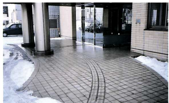
■視覚障害者にも配慮した点字ブロックを設けている。
