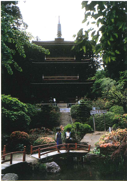
しょうわ 昭和時代に建てられた三重の塔 なんぶ ほうこうじ (南部町の法光寺)
