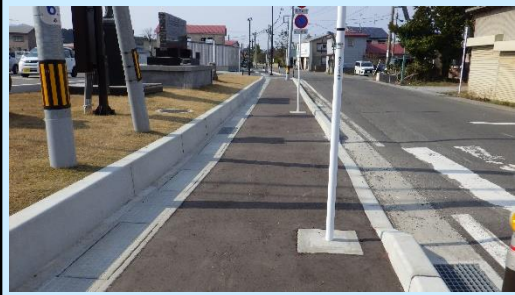
■基幹事業（道路） 市道伊勢道1号線
