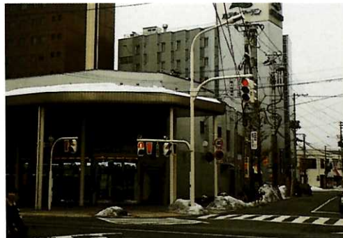
■信号、照明施設等の支柱を共有化し、かつ色彩の工夫により、周辺景観と調和させている
