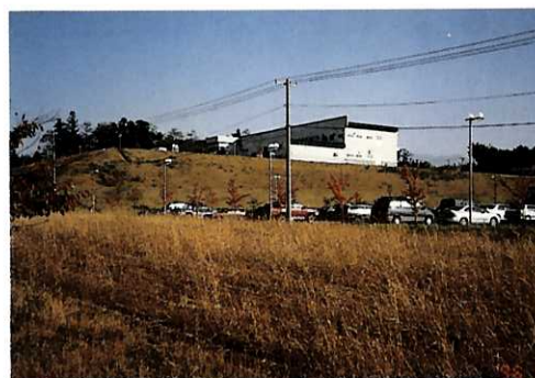
■ 法面を緑化することにより、周辺景観との不調和の軽減を図っている
