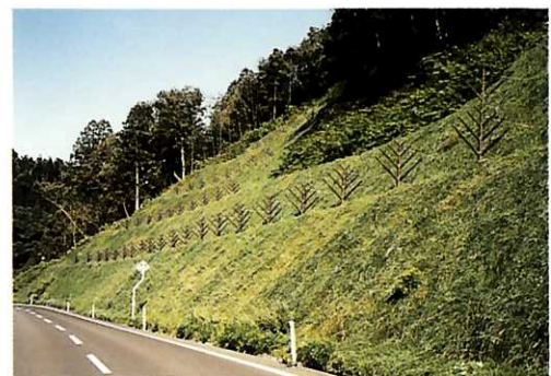
■雪崩防止工のデザインの工夫により、冬期以外における周辺景観との調和を図っている
