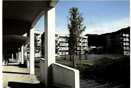
■防雪通路が建物本体と一体的なデザインとなっている
