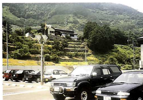
■ 地形を分節化し、擁壁の高さを低くすることにより、周辺景観との不調和の軽減を図っている
