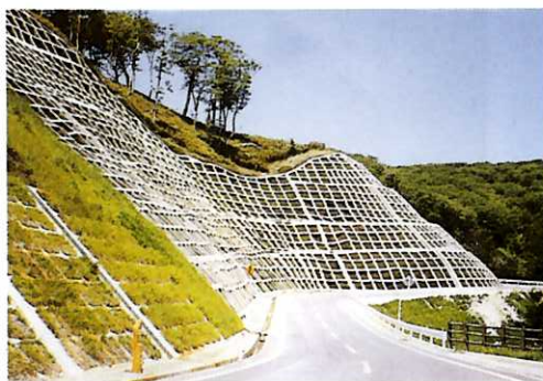
■急なこう配の法面においても緑化が行われている
