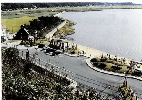
■ ゆとりの駐車帯の整備により、展望広場を確保している
