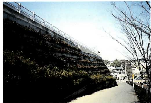
■緑化ブロックにより周辺景観との調和を図っている
