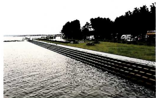
■階段護岸の採用により、親水性を確保している
