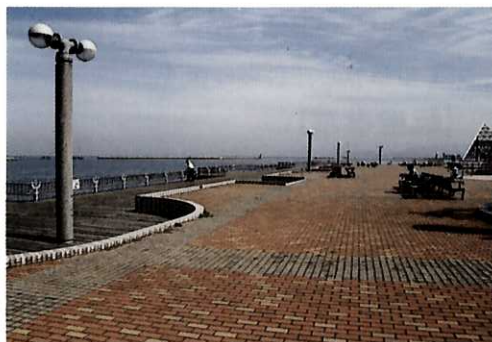
■ブロック舗装のデザインを工夫し、潤いのある空間を創出している
