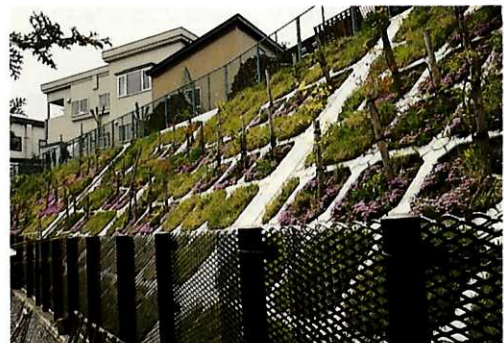
■法面に低木（つつじ）と草花を植栽している
