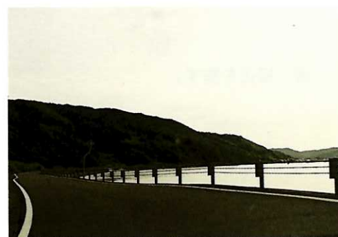
■ガードロープにより眺望を阻害しないよう配慮している
