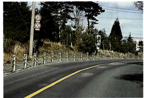
■可動式の防護柵を採用し、除雪作業に配慮している
