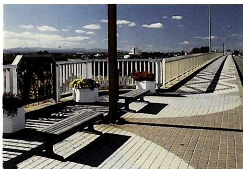
■ 橋上に小広場を設け、眺望点としての機能の創出を図っている
