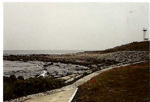
■自然石を用いた護岸の整備により、良好な海浜の保全を図っている
