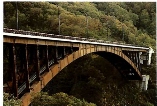
■ 桁の色彩を低明度・低彩度とし、自然景観との調和を図っている
