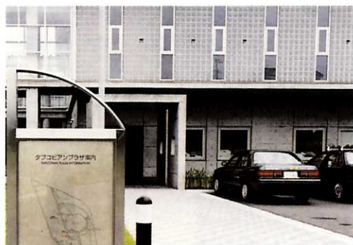
■ 意匠を工夫し、素材の形態の変化により壁面が単調にならないよう配慮している
