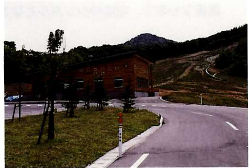
■ 勾配屋根が採用され背後の山稜線 りょう と調和を図っている
