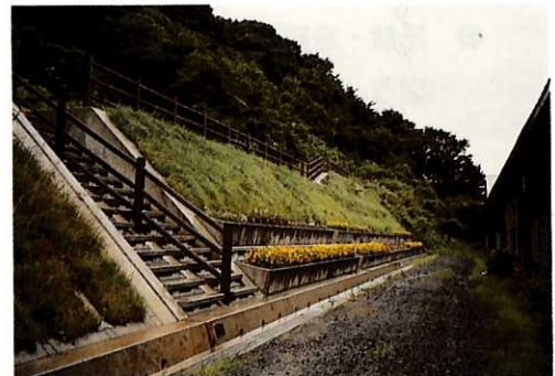
■コンクリート法枠の中を緑化し、周辺景観との調和を図っている
