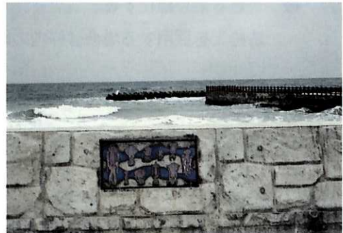
■化粧型枠を使用し、楽しさを演出している
