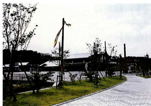
■デザインを統一し、まとまりのある景観を創り出している
