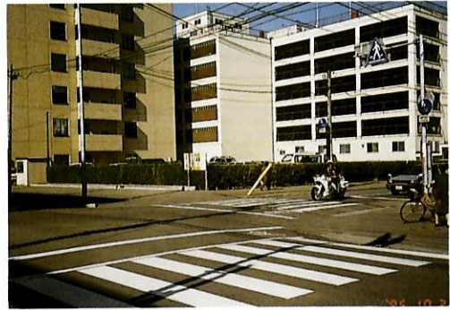
■ 建築物の撤去後の跡地の周囲を緑化することにより、周辺景観との調和を図っている
