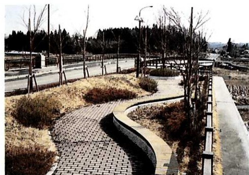
■橋詰に広場を設け、歩行者空間のゆとりを確保している
