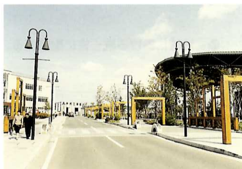
■照明施設の形態等の工夫により、周辺との調和を図りながら、沿線の統一性にも配慮している
