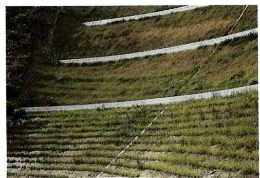
■法面を緑化し、周辺の緑の保全に配慮している
