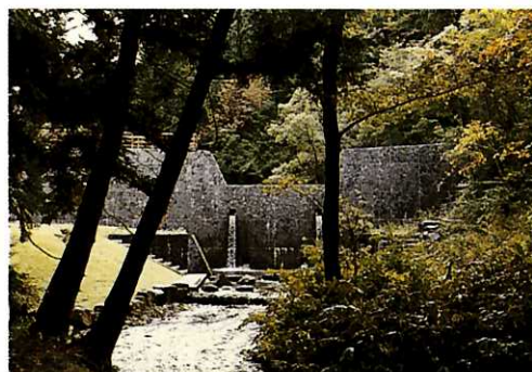
■ 周囲の緑化と表面処理により、周辺の自然景観と調和させている
