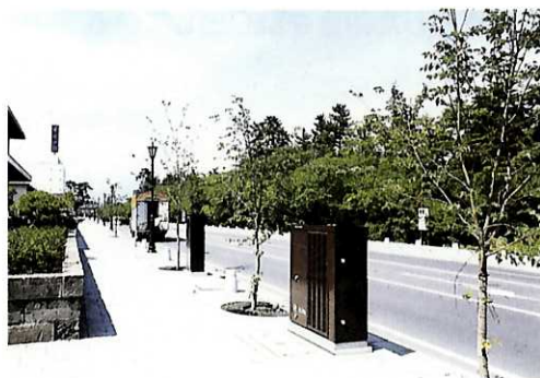
■配電塔の位置を工夫することにより、歩行者空間を確保している
