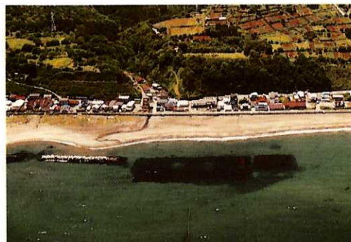
■ 景観阻害要因となる消波ブロックの代わりに人工リーフを用いることで、周辺景観の保全を図っている
