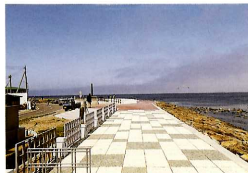
■ 石材を用いた緩傾斜護岸により、海と陸の連続性に配慮されている
