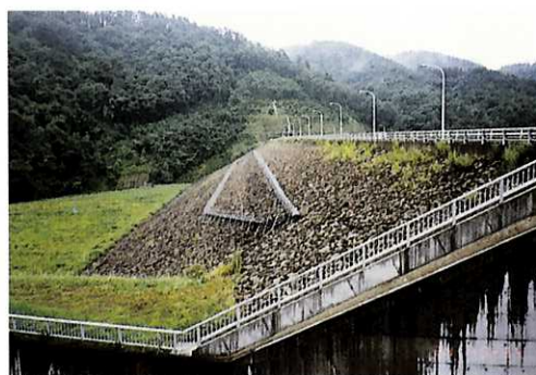
■ ダム本体が周辺景観と調和した形態となっている
