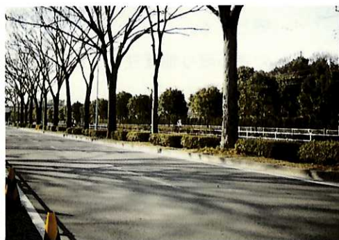
■ 植樹等により中央分離帯の緑化を図っている
