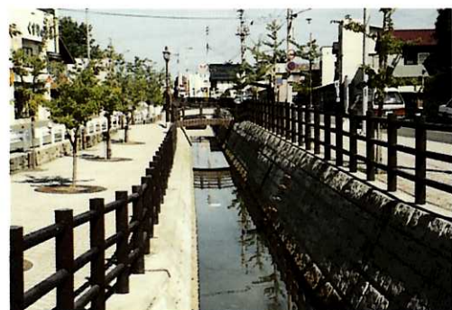
■化粧型枠による表面処理を施し、周辺との調和に配慮している
