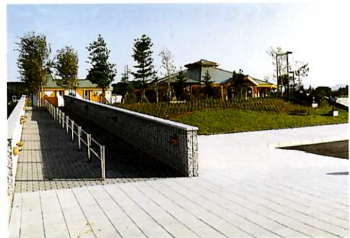
■ 車いすでも建築物へ入れるようスロープを設置している
