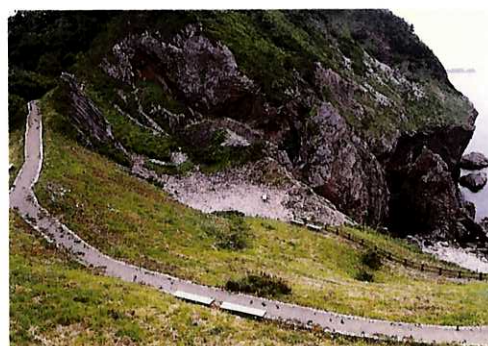
■園路の舗装、柵を周辺との景観と調和させている
