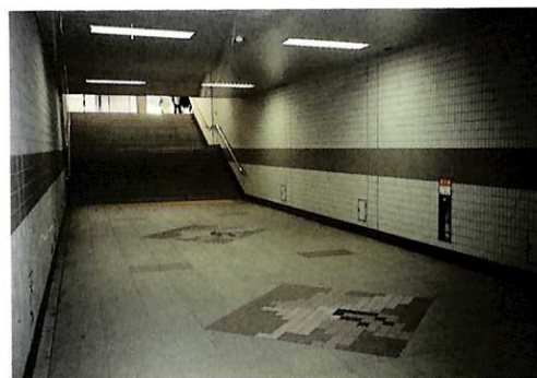
■内装に明度の高い色彩の素材を用い、かつ壁面のデザインの工夫により、圧迫感の軽減を図っている
