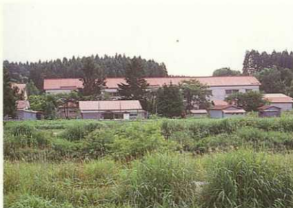
屋根色を統一することにより、集落のまとまりが形成されています。
