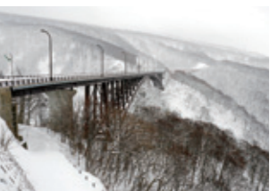
寒そう... (冬の城ヶ倉大橋)
