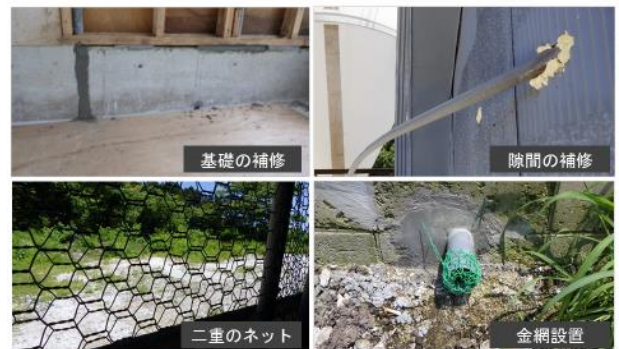
図5 家きん舎の補修
