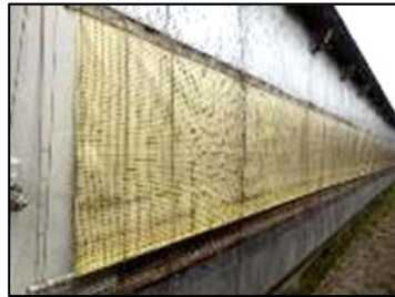
〔防鳥ネットの設置〕
