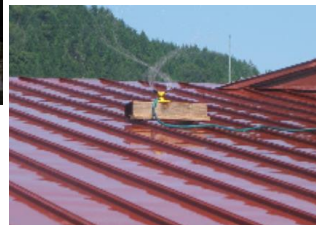
屋根への散水
