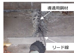
写真-4 電位計測状況
