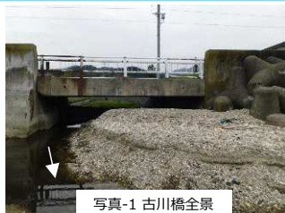
写真-1 古川橋全景
