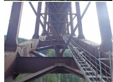
座屈拘束ブレース 交換完了
