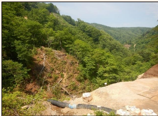
着工前（平成28年5月30日）
