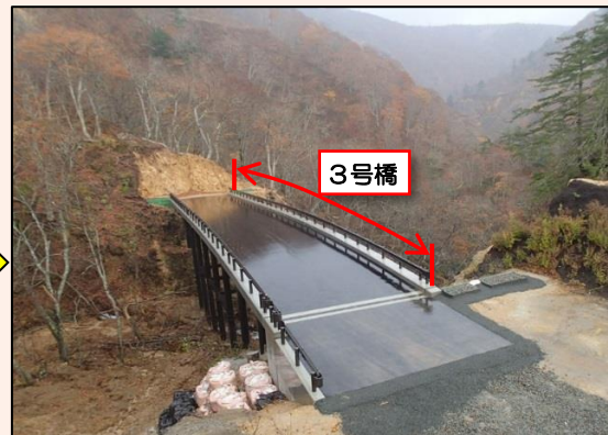
完成状況（平成28年11月5日）
