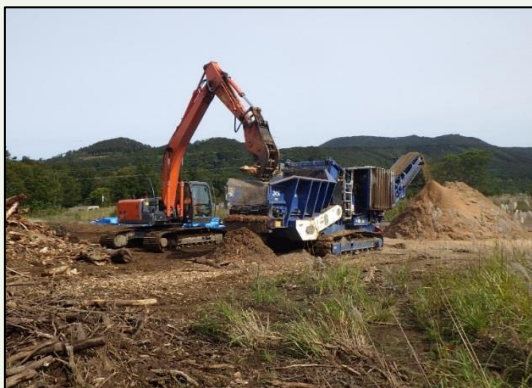
伐木材破碎状況（平成28年9月30日）
