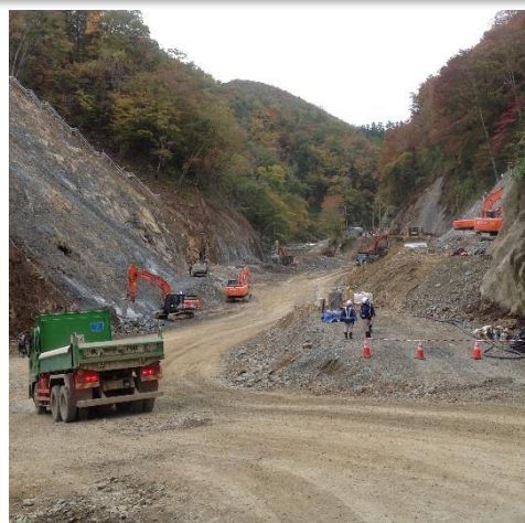
掘削状況（河床部）
