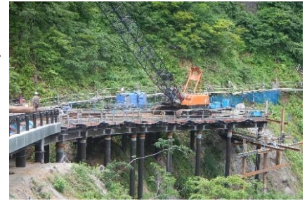
施工状況（H30.7.23撮影）
