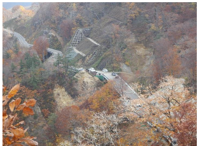
工事中の4号工事用道路を説明(1号工事用道路から)
