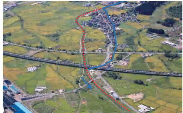
天田内川総合流域防災事業
