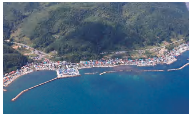
小湊港間木地区 (地方創生推進交付金事業)
