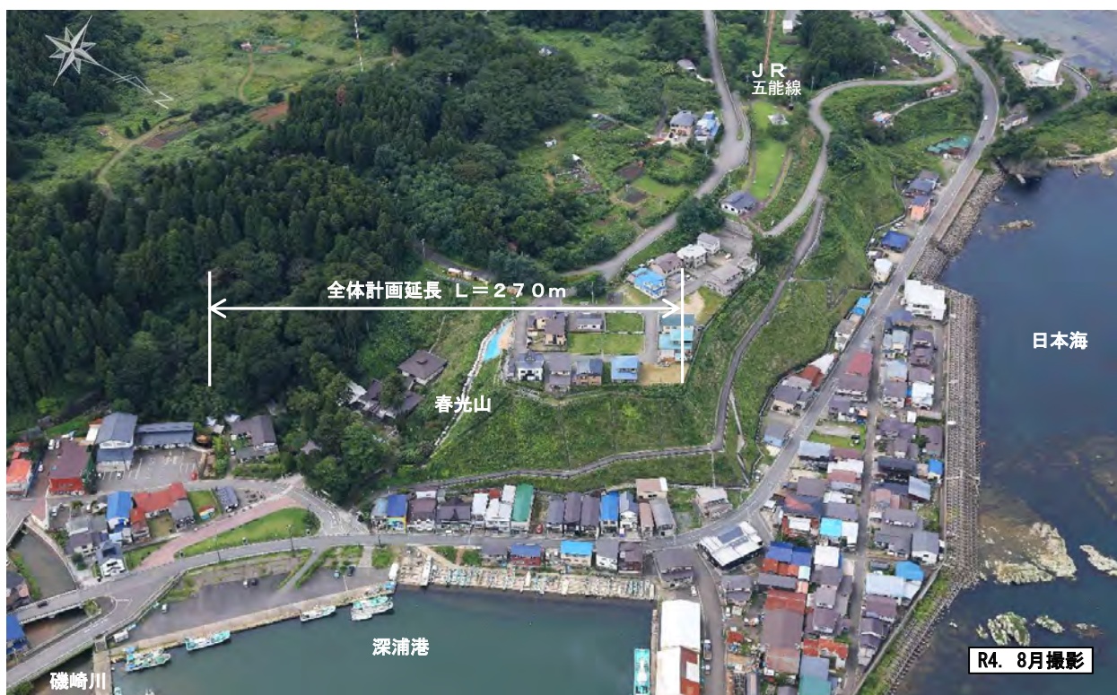
岡崎2号区域急傾斜地崩壊対策事業（深浦町）
