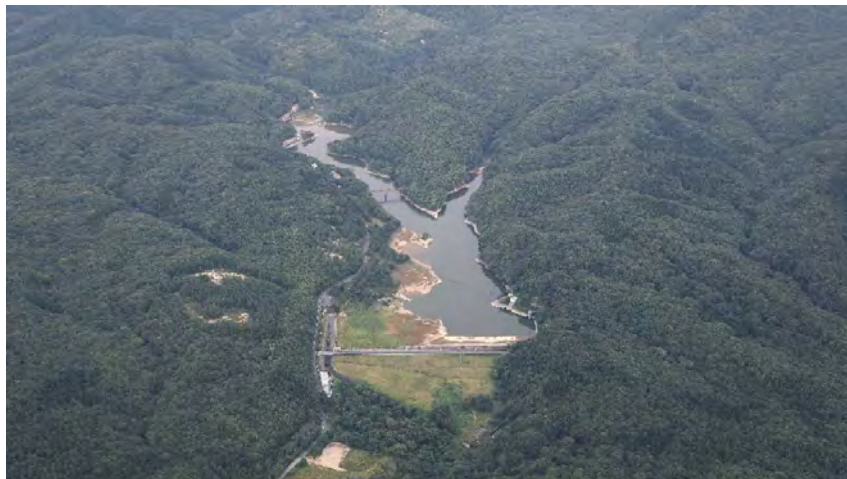
飯詰ダム (五所川原市)
