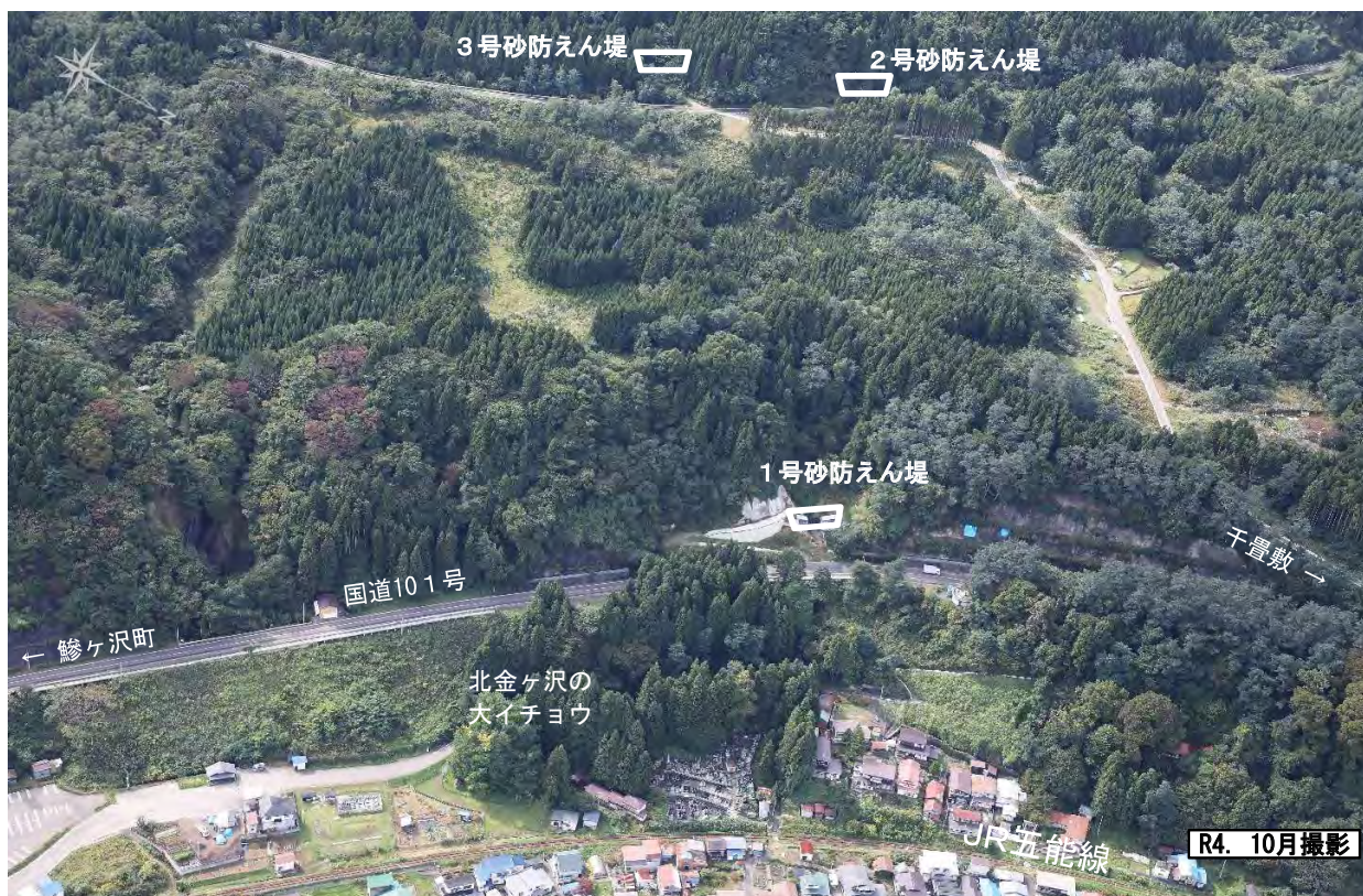
トモエ沢砂防えん堤(深浦町)
