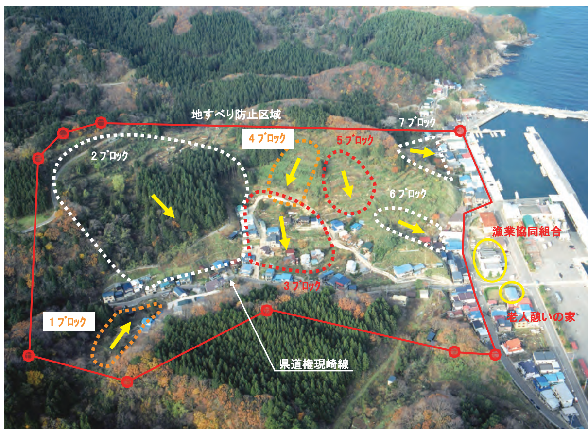
大山長根区域総流防地すべり対策事業（中泊町）
