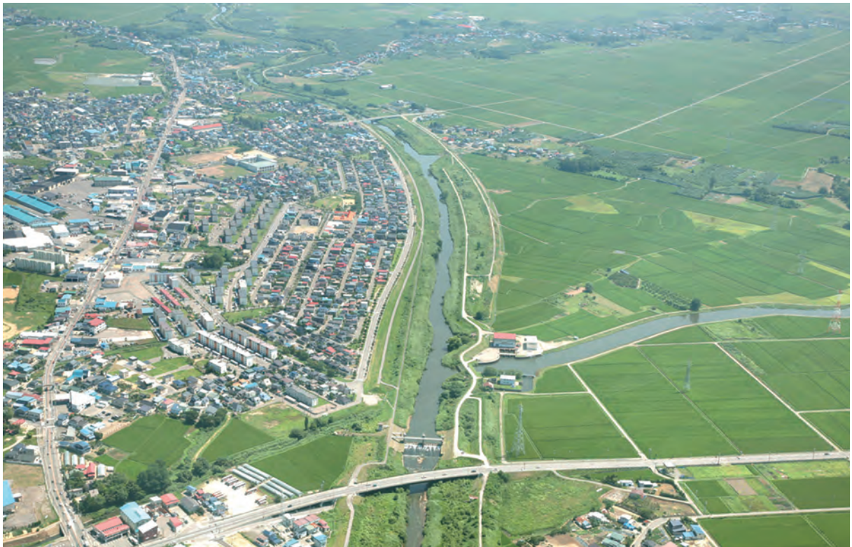
十川広域基幹河川改修事業（五所川原市）
