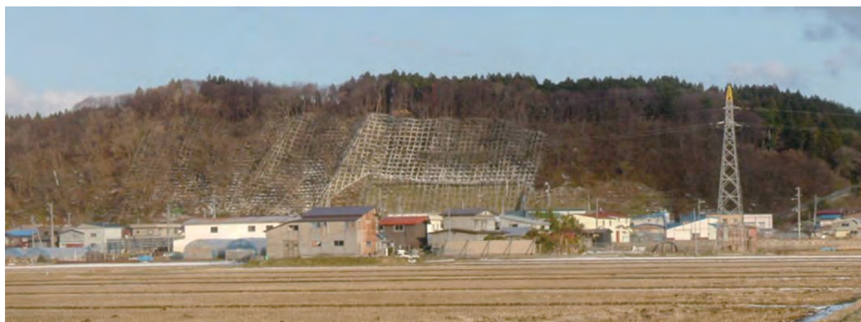
玉清水区域急傾斜地崩壊対策事業（中泊町）
