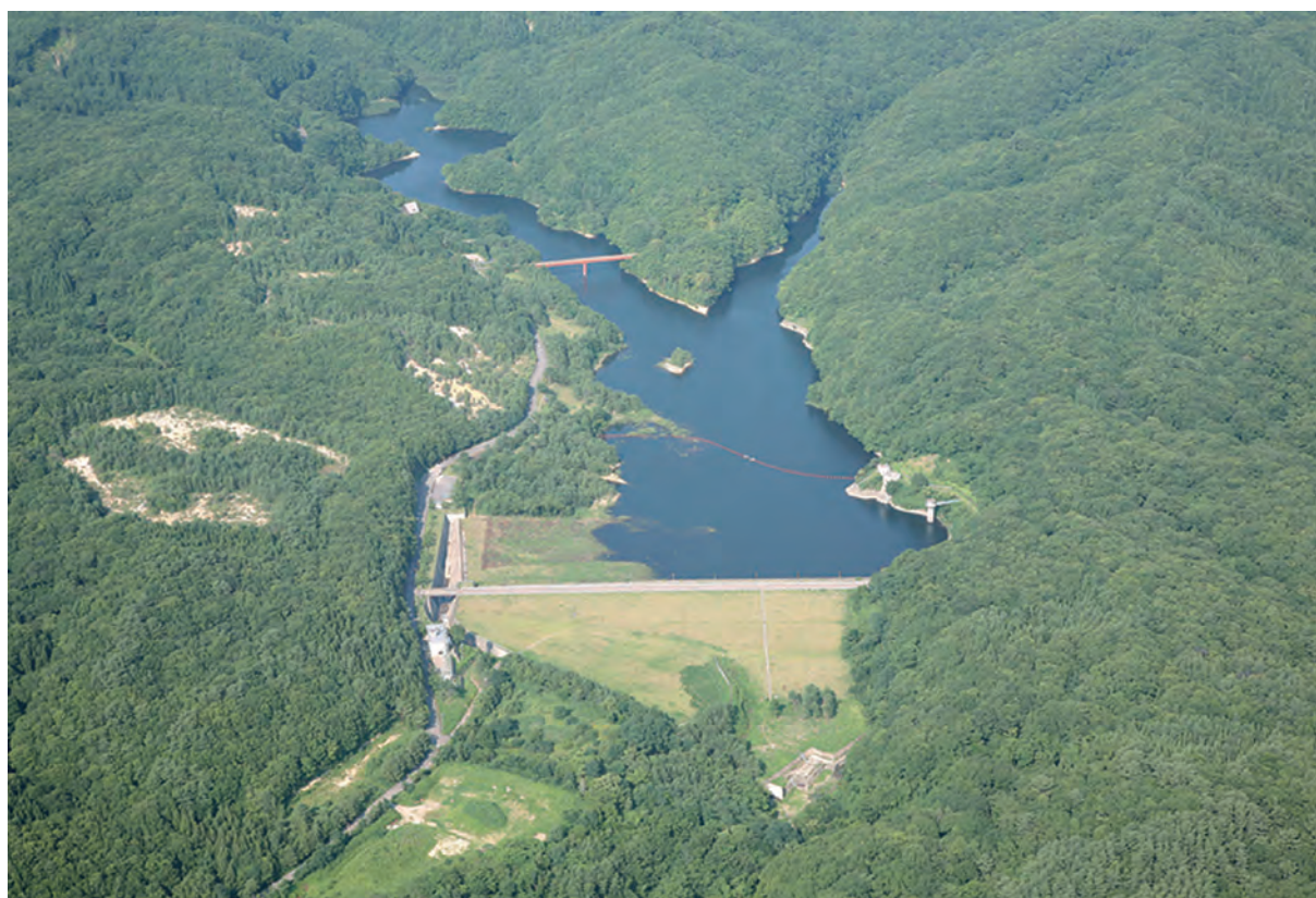
昭和47年度に完成した飯詰ダム（五所川原市）
