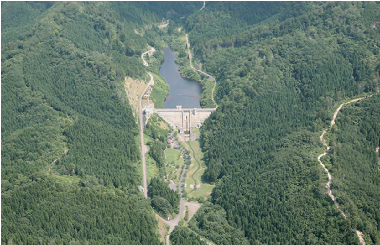
平成8年度に完成した小泊ダム（中泊町）
