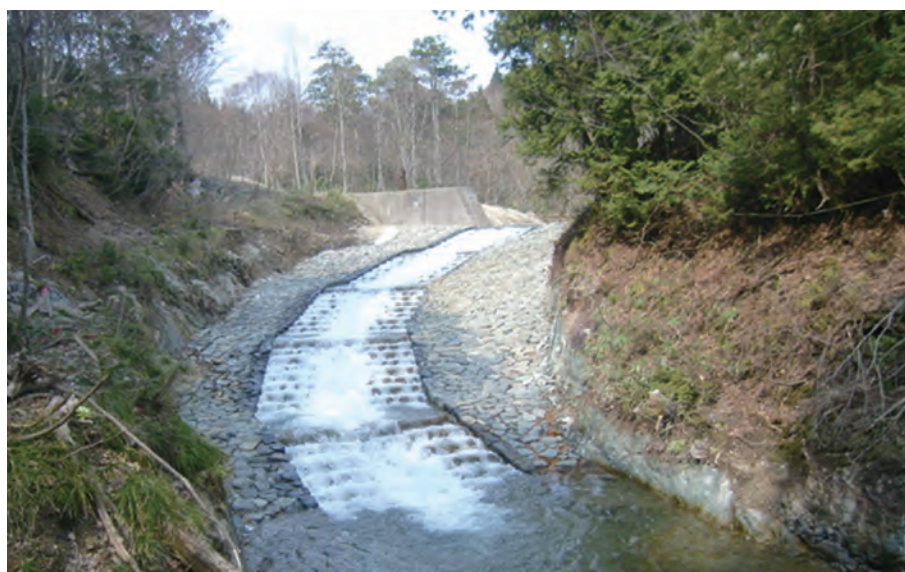
太田川砂防整備事業(中泊町)
