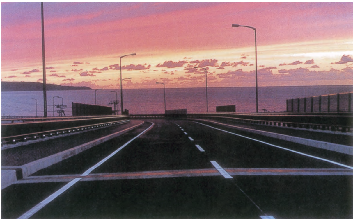
国道 101 号国道改築事業（鱒ヶ沢バイパス：鱒ヶ沢町）
