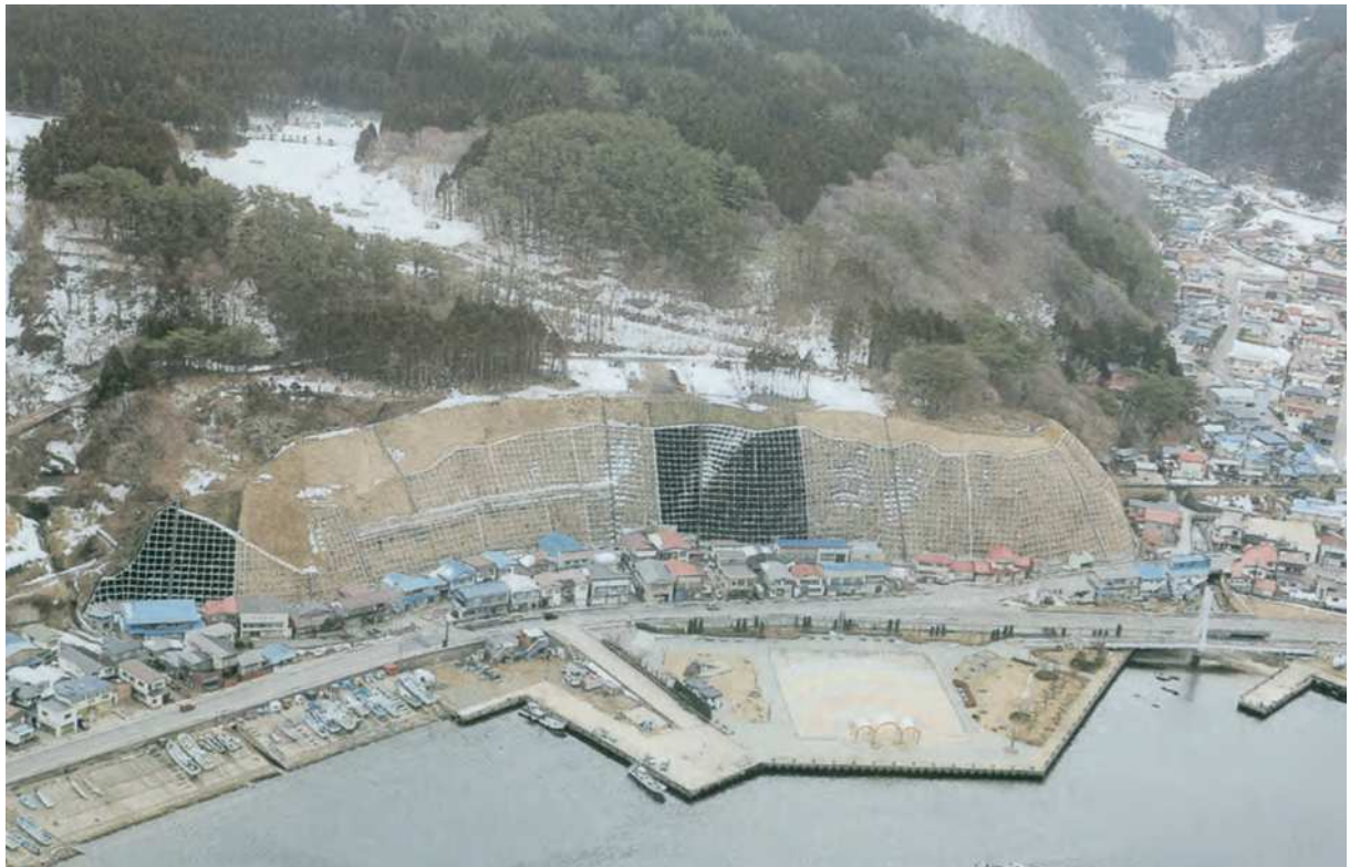
浜町2号区域急傾斜地崩壊対策事業（深浦町）
