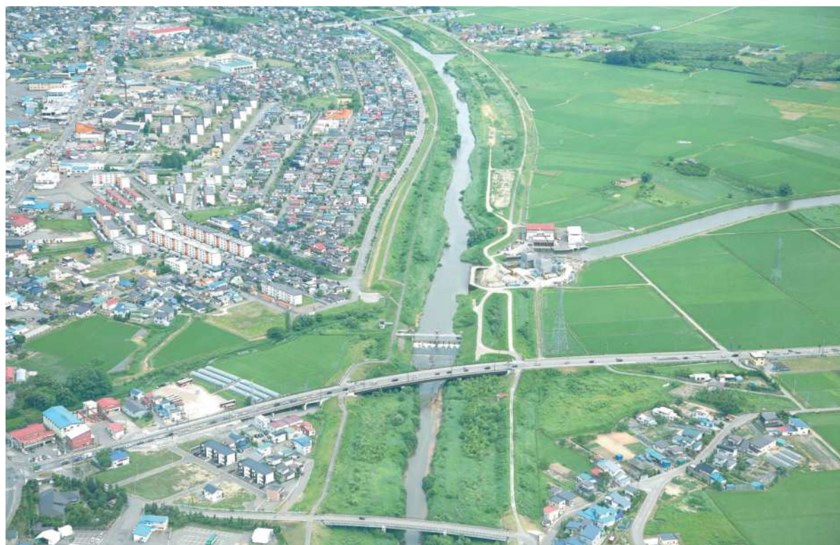
十川広域河川改修事業（五所川原市）
