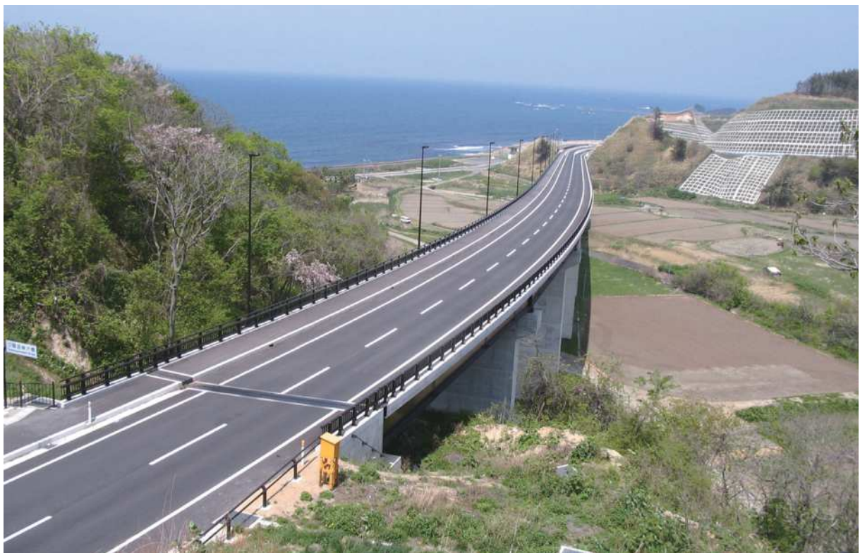
国道101号国道改築事業（追良瀬バイパス：深浦町）
