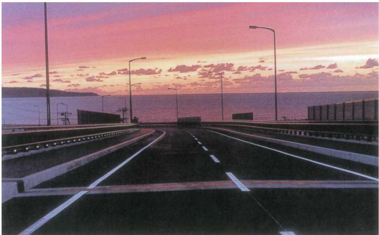
国道 101 号国道改築事業（鱈ヶ沢バイパス：鱈ヶ沢町）
