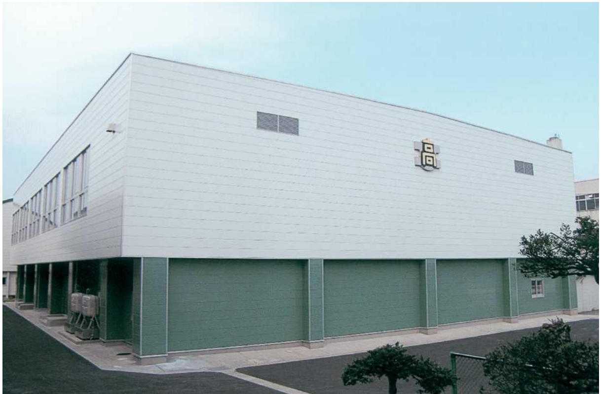
五所川原工業高等学校第一体育館
