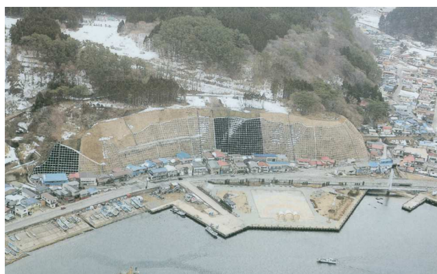
平成19年度完成 浜町2号区域急傾斜地 崩壊対策事業(深浦町)
