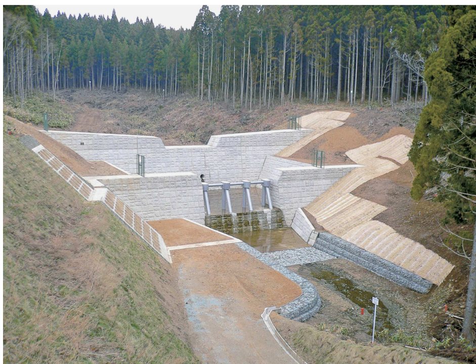
平成22年完成 吉花沢1号堰堤(深浦町)
