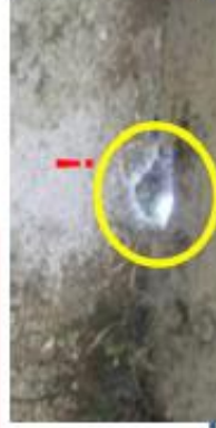
壁や床の破損がないか(外の 光が漏れている所は要注意)
