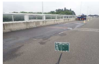
舗装擦り付け
