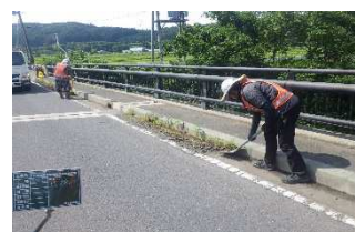
清掃工（土砂撤去）
