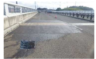
緊急措置完了
