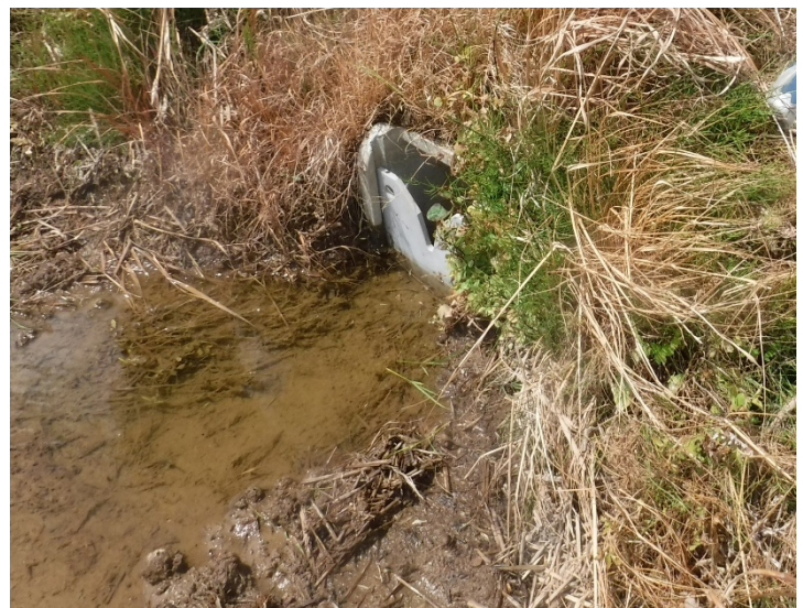
大川平地区に設置した田んぼダム
