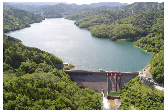
天間ダム（下流から上流を望む）
