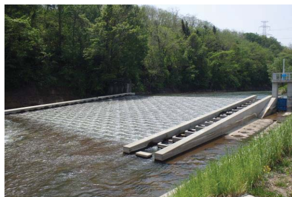
頭首工 上川原地区（三戸町）
