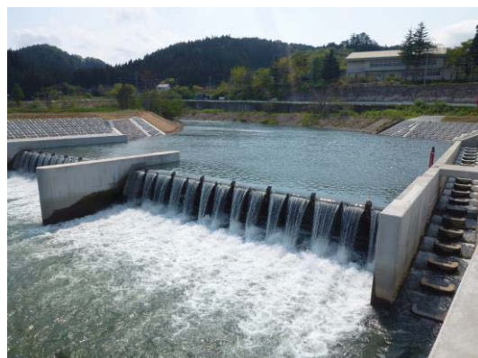
頭首工 鱒ヶ沢堰地区（鱒ヶ沢町）
