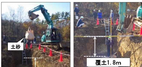
図-6 埋却作業の確認
