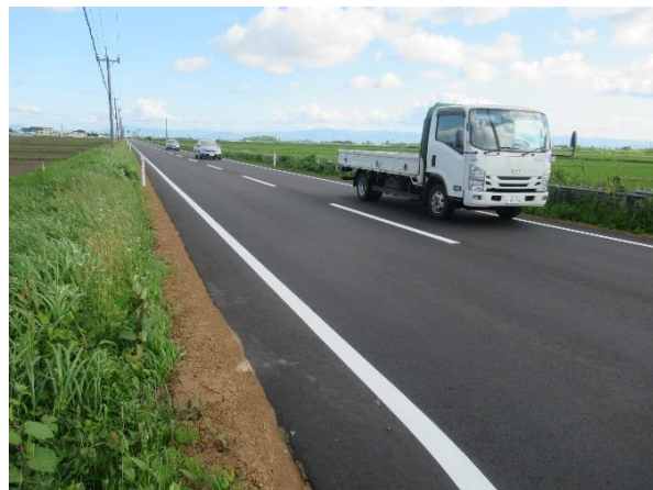
通作条件整備事業 舗装工 (五林平地区 板柳町 R3～R5)
