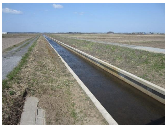
県営岩木川左岸 3 期地区かんがい排水事業により整備を行った水路
