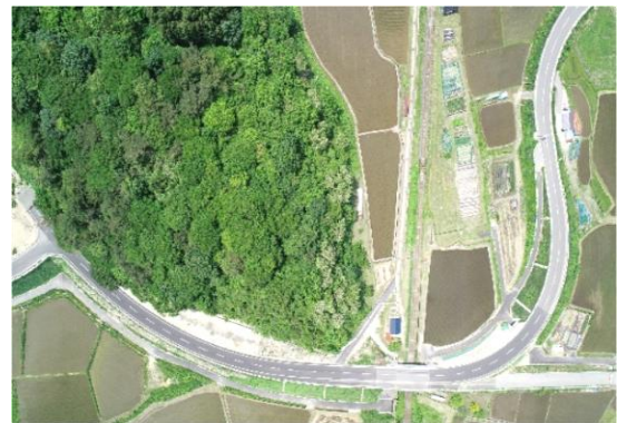
広域営農団地農道整備事業 道路工 (西海岸関地区 深浦町 H28～R5)
