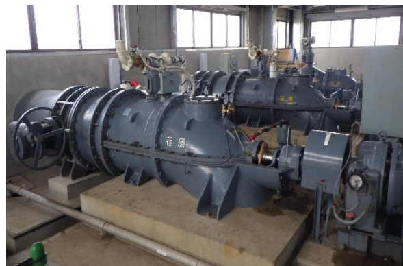
農業水路等長寿命化・防災減災事業 (車力排水機場地区 つがる市 R2～R5)
