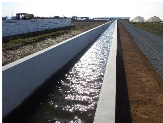
農業水路等長寿命化・防災減災事業 (東俣4号用水路地区 つがる市 R2～R5)
