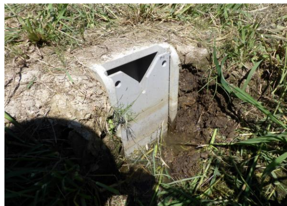
落水口に設置した堰板
