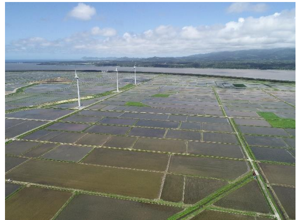
大区画ほ場整備を進めている十三湖地区
