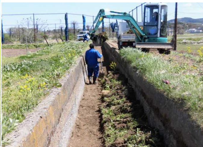
【水路の泥上げ作業の様子】
