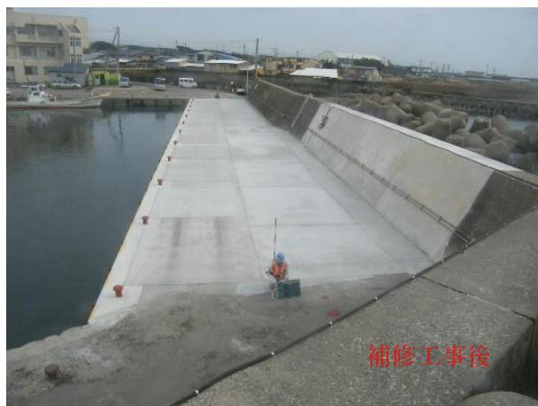
施設建設後、数十年が経過している施設が数多くあり、老朽化の進行とともに機能が低下していることから、機能保全計画に基づいた対策工事を行い、施設の長寿命化と更新コストの縮減を図っている。
