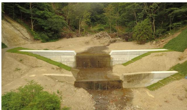
溪流の侵食を防止し溪床の安定、山脚の固定及び土砂の流出の抑止・調整を図るため治山ダムを設置。
