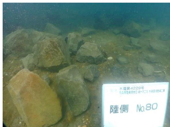
マコガレイなどの保護・育成場となるアマモ場の保護を目的とした基質ブロックを設置するとともに、ウスメバル稚魚などの着生を促す藻場造成を目的として、石材による増殖場を整備している。
