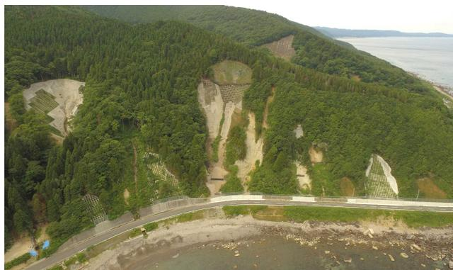
豪雨で崩壊した山腹斜面の安定を図るため、簡易吹付法砕工を実施。
