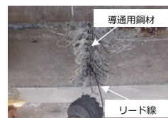
写真-4 電位計測状況
