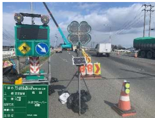
視認性の良い交通規制材の設置
