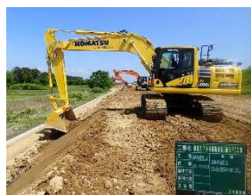
【GNSSによる盛土締固め】
