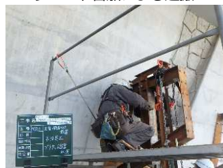
分割小型化による人力施工
