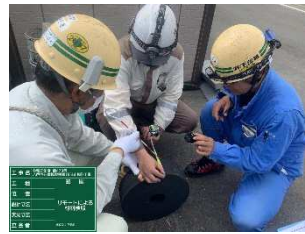
遠隔臨場による施工検査
