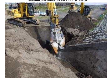
既設堤防取壊し状況
