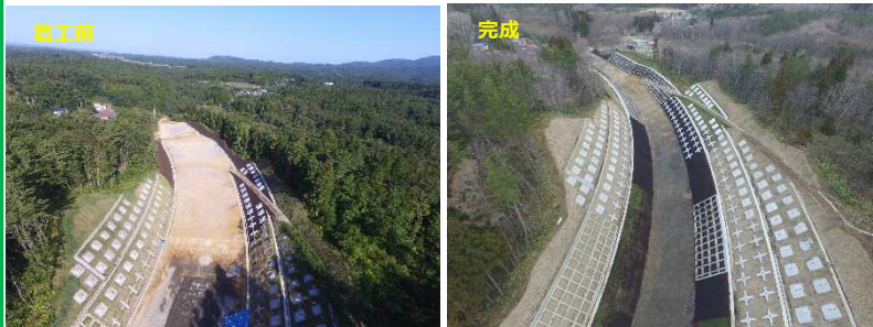
【施工管理】ドローンによる 着工前・完成写真管理
