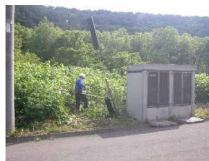
現場周辺の草刈り
