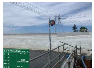
カメラ設置による現場把握
