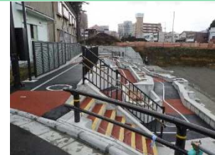
完成【Bブロック】起点側
