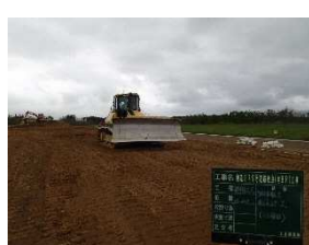
【GNSSによる盛土締固め】
