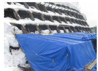
法面除雪・養生小屋設置
