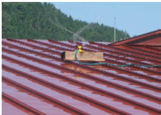
屋根への散水
