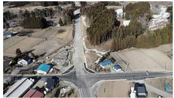
国道394号(榎林バイパス)工事(七戸町)
