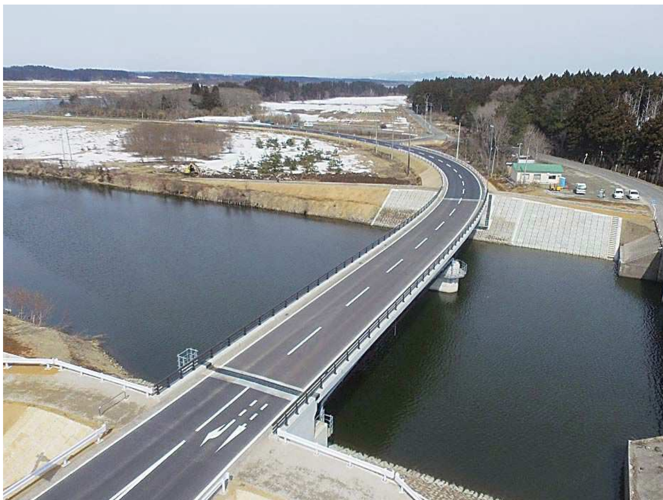
写真：国道338号 橋梁架替(高瀬川第二橋)事業
