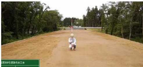
完成（本線土工）
