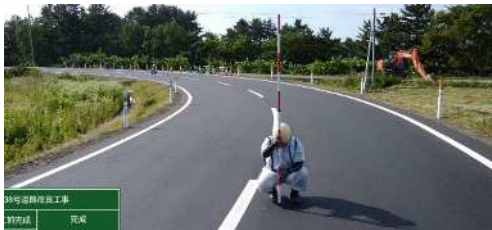
完成（取付県道舗装）
