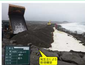
現地発生土による築堤
