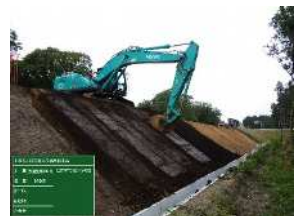
法面整形(ICT)
