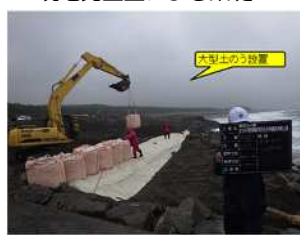
土木シート展張後大型土のう設置
