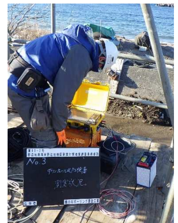
P・S検層状況写真
